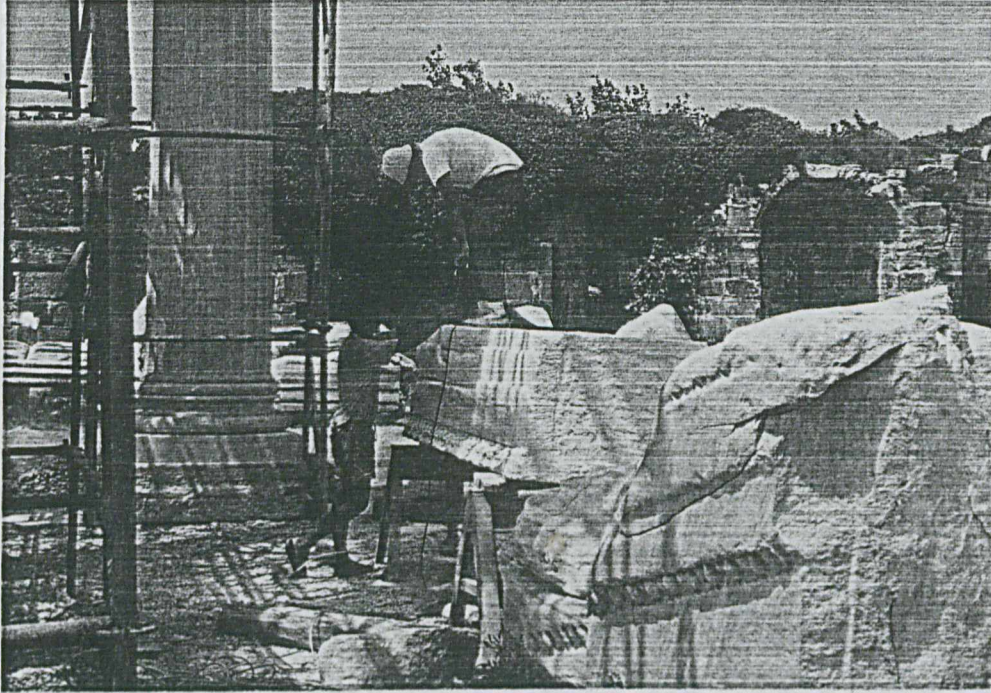
F.2 D.5'e donatı tesbiti için delik açılıyor
