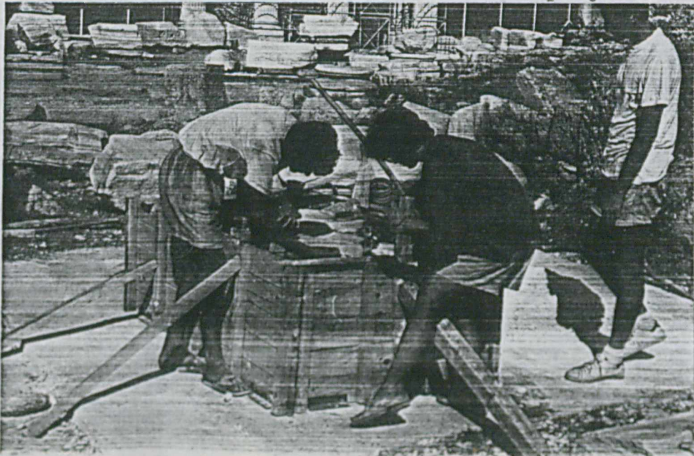
F.16 E 11 friz bloğu kalıba alındıktan sonra. Bütünleme betonu dökülmeden önce Araldit epoxybond sürülüyor
