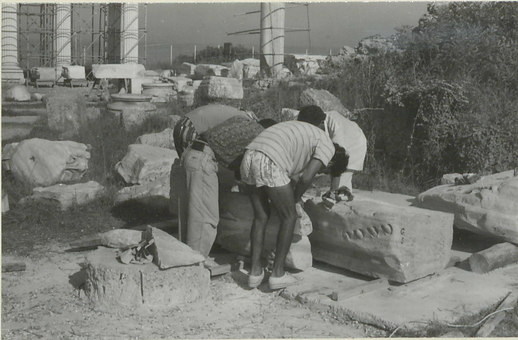
23. G 5 alınlık bloğuna ait parçalar birleştiriliyor
