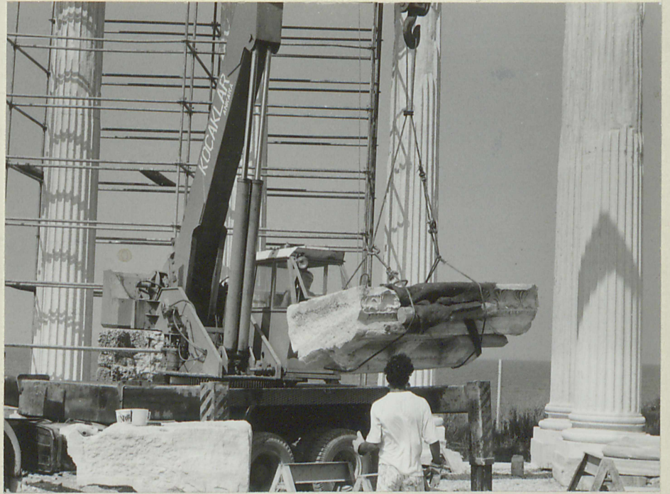
34. F 24 eğik korniş bloğu kaldırılıyor
