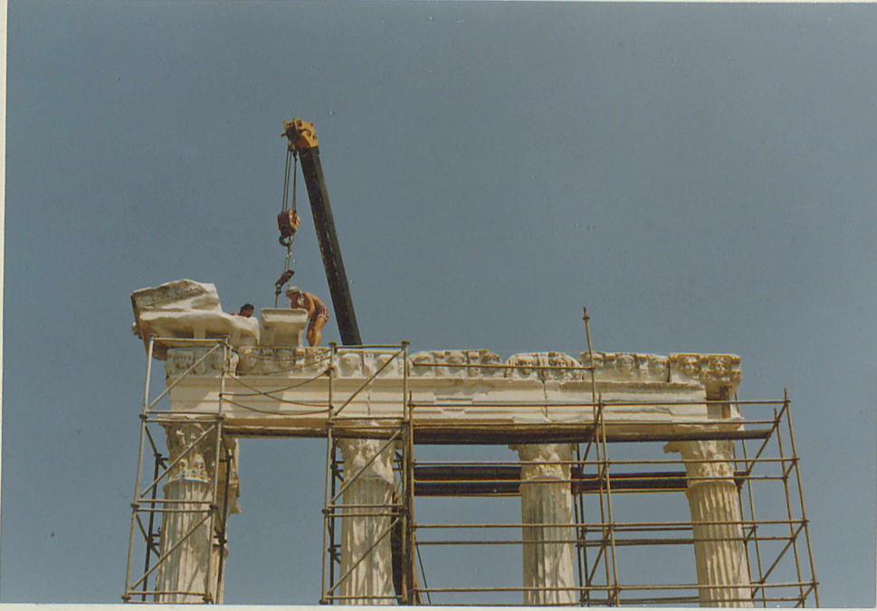
20. F 19 yatay korniş bloğu yerleştiriliyor
